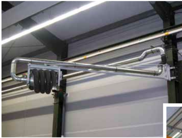
Elektrischer Aufroller am 6 m langen Schwenkausleger
