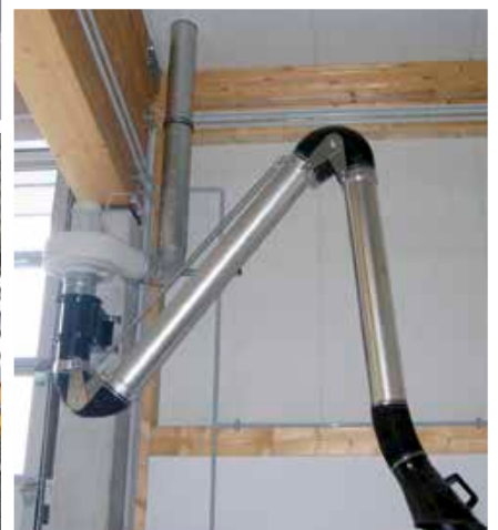
Links: Elektrischer Aufroller mit zentralem Ventilator. Unten: EXA-Absaugarm 4 m mit Ventilator
