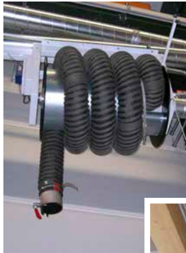
Links: Elektrischer Aufroller mit zentralem Ventilator. Unten: EXA-Absaugarm 4 m mit Ventilator
