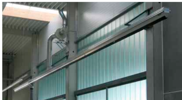
Oben: Saugschlitzkanal mit Schlauchwagen und leistungsstarkem Ventilator. Links: EXA-Spezialadapter für Mähdrescher und Häcksler
